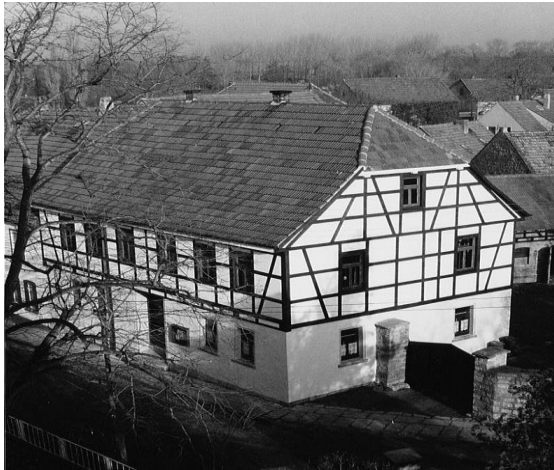
Das 1836 nach Plänen von Clemens Wenzelslaus Coudray neu erbaute Pfarrhaus in Ollendorf (heute Lange Gasse Nr. 103)
